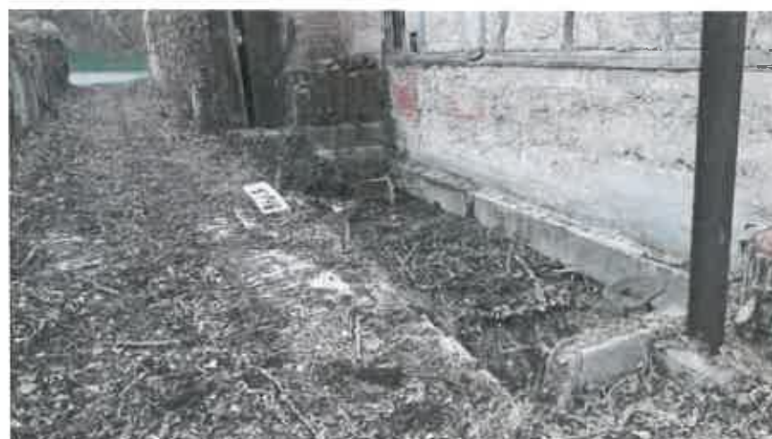
Abb. 9: Die ehemalige Güllegrube ist stark vermüllt
