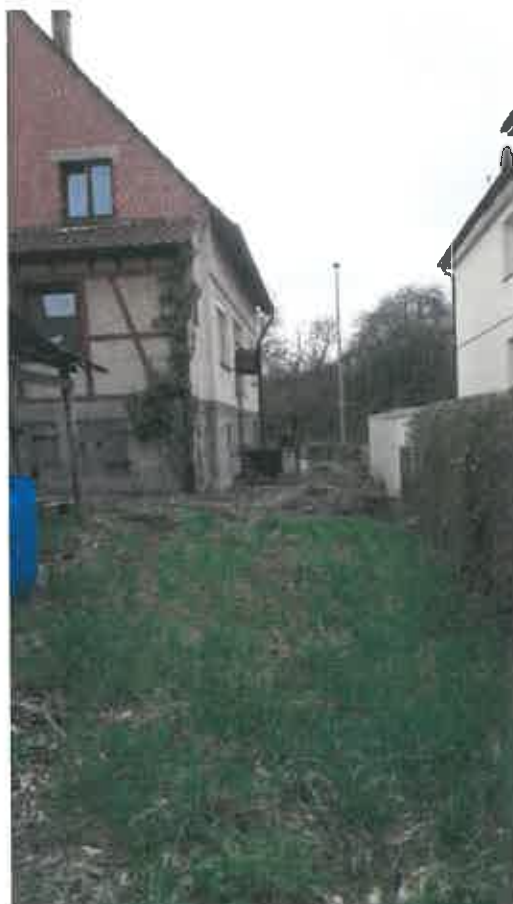
Abb. 6: Ansicht Wohnhaus aus Richtung Nord
