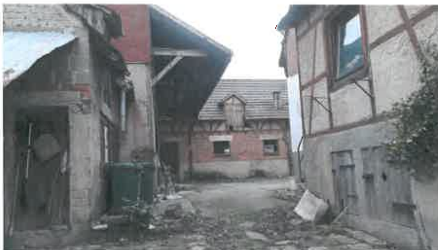
Abb. 7: Freifläche/Zufahrt zwischen Scheuer und Wohnhaus
