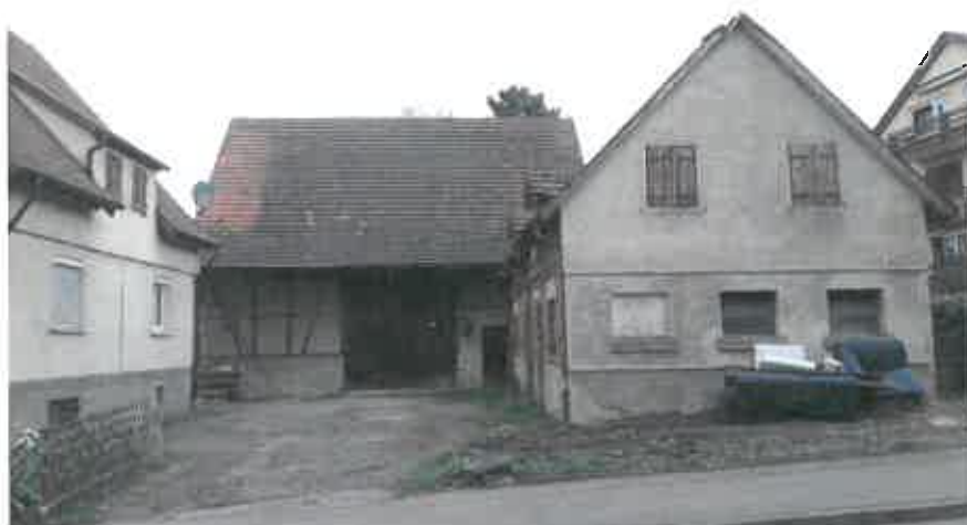
Abb. 3: Ansicht Scheuer von der Affalterbacher Straße aus
