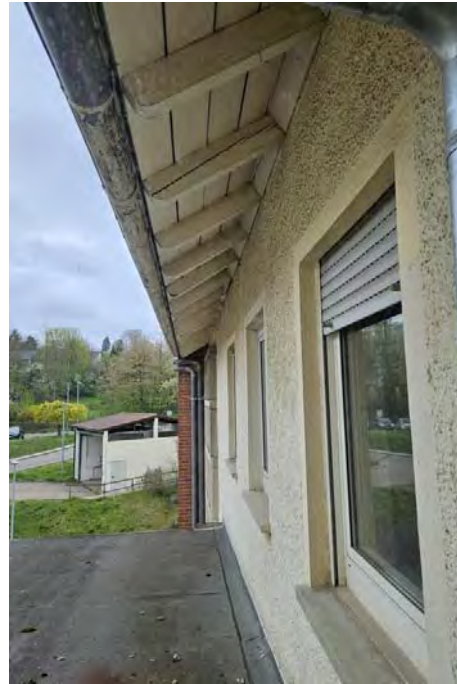
Abb. 7: Untersuchung der Dachüberstände auf Spalten und Einflugöffnungen sowie Hangplätze
