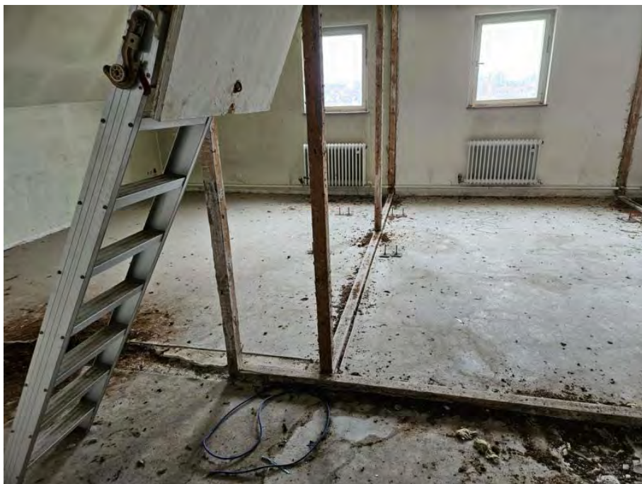
Abb. 13: Teilweise sind Dachstühle und obere Stockwerke ausgebaut
