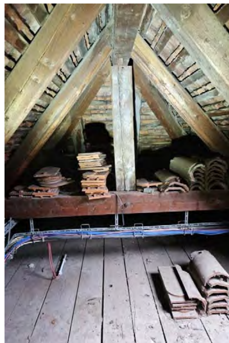
Abb. 17: Innenansicht vorstehende Abb., für Fledermausarten ungeeignete Habitatstrukturen ohne Einflugmöglichkeiten.
