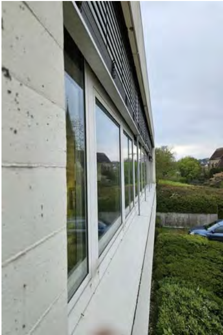
Abb. 6: Untersuchung der Fenstersimsen auf Hinweise Fledermausarten/ Hangplätze unter Außenrollladen
