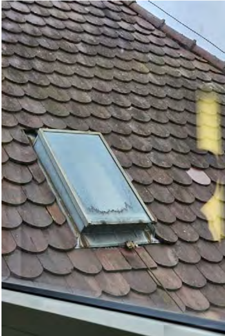
Abb. 10: Die Dachfenster sind verschlossen, Einflugstellen wie z.B. fehlende Dachziegel sind nicht vorhanden.
