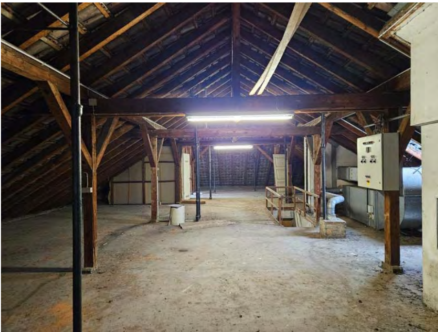
Abb. 12: Innenansicht Dachstuhl vorstehende Abb.
