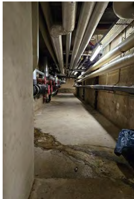
Abb. 9: In den Kellerräumen sind vornehmlich Haustechnik und Werkstätten untergebracht
