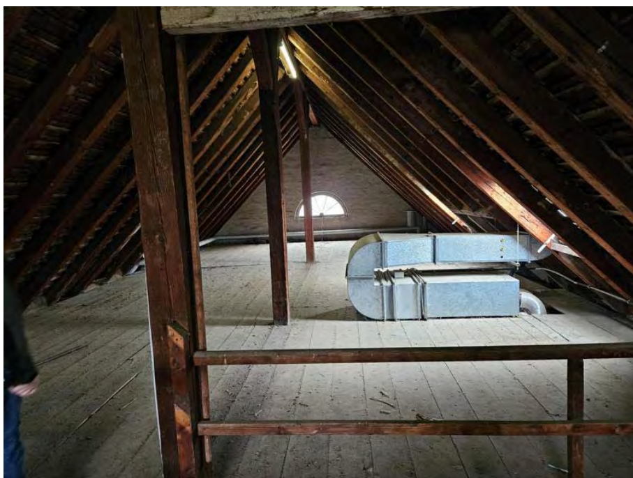
Abb. 14: Dachstuhl über dem Mittelbau, durch große Fenster an der Nord- und Südseite sehr hell. Der Dachstuhl ist einer der wenigen noch aus dem Ursprungsbau erhaltenen Gewerke.
