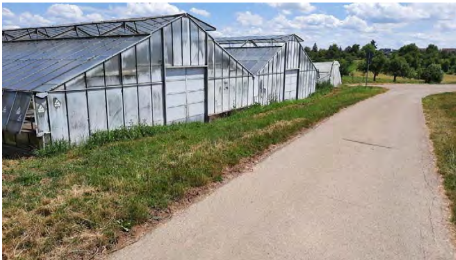
Abb. 2: Westseite des Gewächshauses
